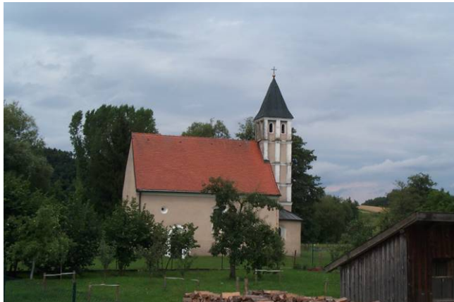
Kirche St. Nikolaus Ansicht von Süden
